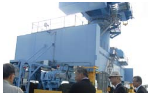
ジブクレーン視察
